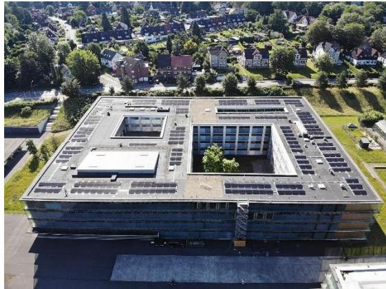
Das Max-Born-Berufskolleg ist mit einer PV-Anlage ausgestattet. Die Anlage ist so ausgelegt, dass ca. 80 % des Solarstroms direkt von der Liegenschaft selbst verbraucht werden, der Rest wird eingespeist.
